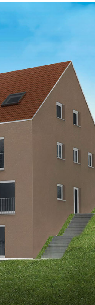
La coopérative Coopélia construit à Vallorbe des logements pour seniors.
