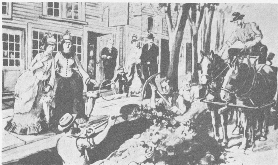
Billede fra udførelse af varmeledninger i Lockport
