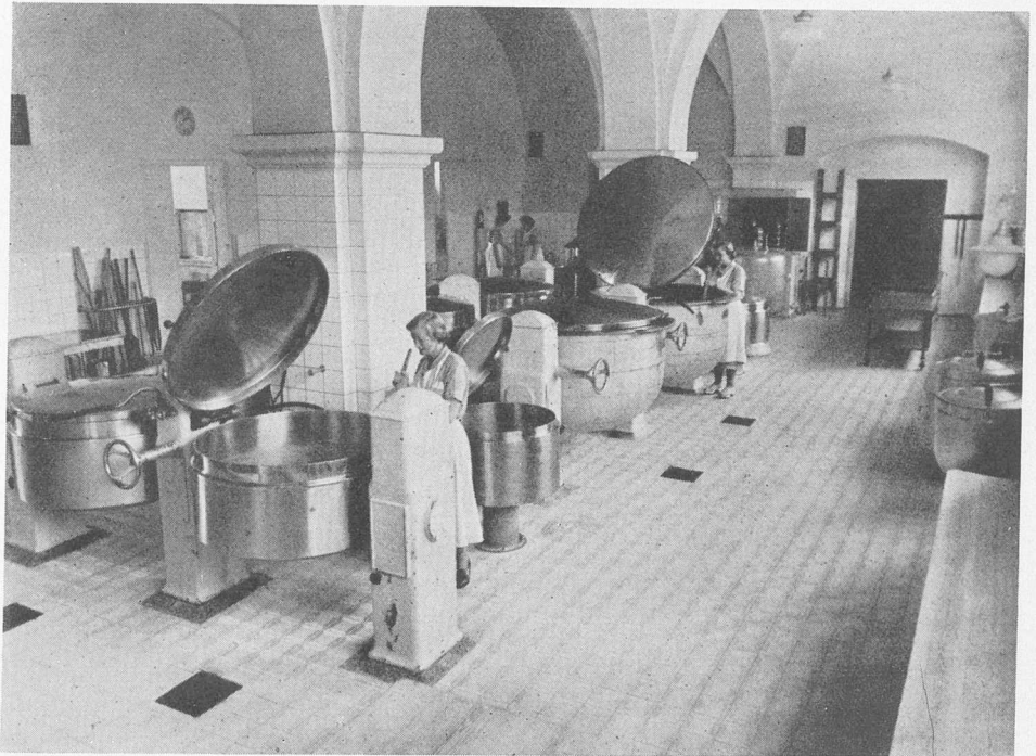
Anvendelse af dampgryder ved madlavning i stort hospitalskøkken.
