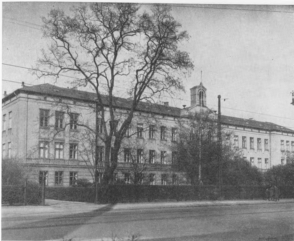
BYGNINGEN FOR BOTANIK OG PLANTEAVL Det tidligere Københavns Sygehjem
