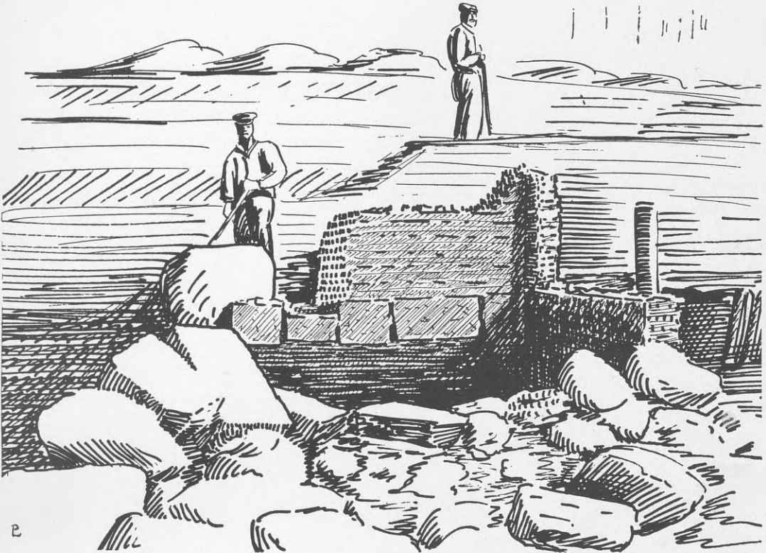
Valkendorfs Brønd under Udgravning.
