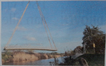
De fietsbrug over het Eindhoven Kanaal moest omhoog getakeld worden zodat de boot van Sinterklaas door het kanaal kon varen. foto Jurriaan Balke
