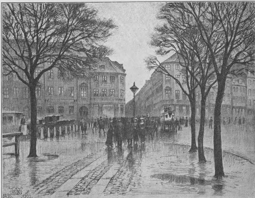
Tom Petersen, 1893-1903: Den gamle Vej for Gaaende fra Frederiksberggade over Raadhuspladsen. Set fra nuværende Sporvognsholdeplads.
