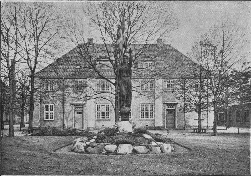
Det ny efter Branden 1918 opførte Kleinsmedeværksted paa Frederiksholm. Gallionsfiguren stammer fra Flaadens sidste Linieskib »Dannebrog«.
