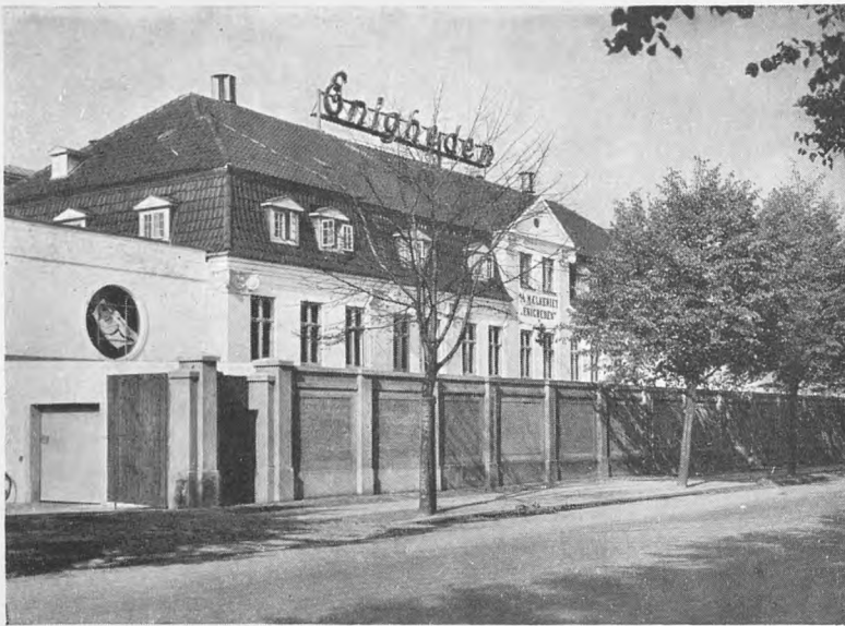
Enighedens Hovedfacade, Lygten 39-41, med Rækken af Kontorvinduer.
