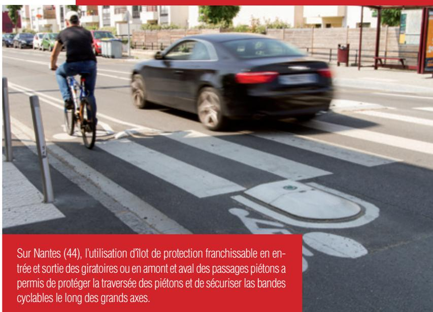
Sur Nantes (44), l'utilisation d'îlot de protection franchissable en entrée et sortie des giratoires ou en amont et aval des passages piétons a permis de protéger la traversée des piétons et de sécuriser les bandes cyclables le long des grands axes.
