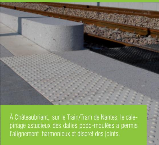
À Châteaubriant, sur le Train/Tram de Nantes, le calepinage astucieux des dalles podo-moulées a permis l'alignement harmonieux et discret des joints.
