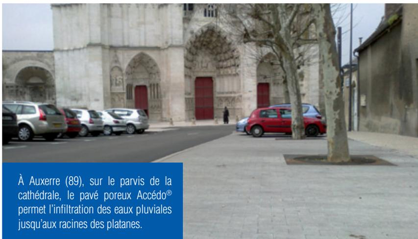
À Auxerre (89), sur le parvis de la cathédrale, le pavé poreux Accédo® permet l'infiltration des eaux pluviales jusqu'aux racines des platanes.
