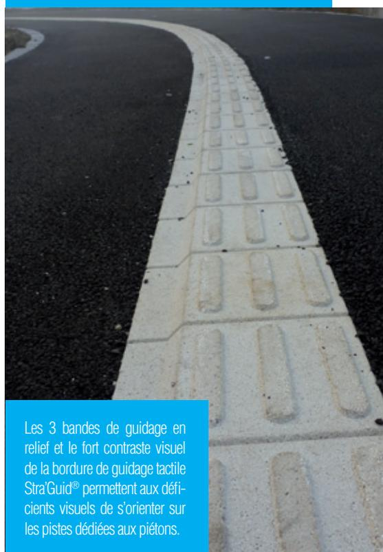
Les 3 bandes de guidage en relief et le fort contraste visuel de la bordure de guidage tactile Stra'Guid® permettent aux déficients visuels de s'orienter sur les pistes dédiées aux piétons.
