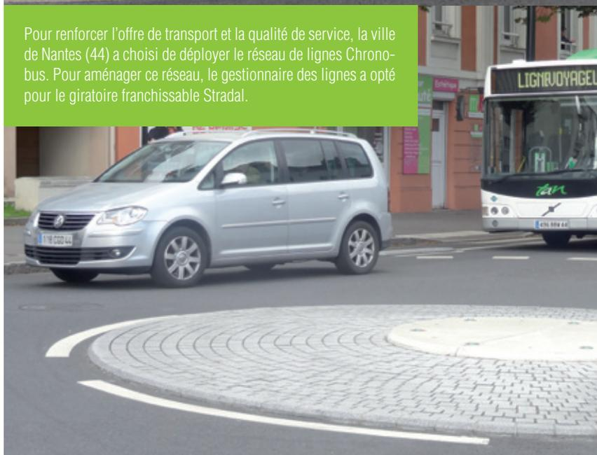
Le mini-giratoire Stradal est une solution idéale pour les carrefours existants en chaussée réduite. En effet, sa modularité lui permet d'être implanté dans toutes les configurations même les plus exigües. Son doux relief d'une hauteur de 40 mm lui permet à la fois de matérialiser le carrefour au sol et d'autoriser son franchissement sans représenter d'obstacle pour les véhicules. Il est un élément de sécurité tout en préservant la fluidité de circulation.
