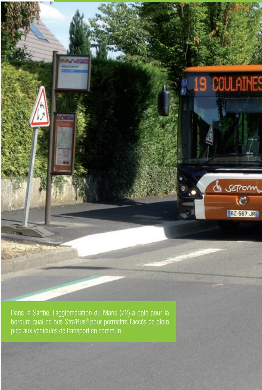
Dans la Sarthe, l'agglomération du Mans (72) a opté pour la bordure quai de bus Stra'Bus® pour permettre l'accès de plein pied aux véhicules de transport en commun
