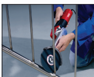
Înlăturarea cordonului de sudură este posibilă acolo unde mașinile convenționale nu reușesc să ajungă
