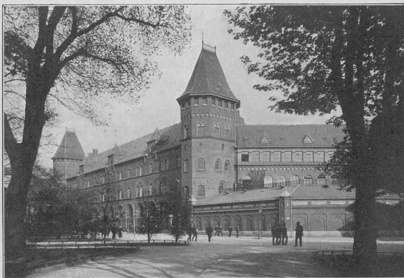
Frilagerbygningen set fra Esplanaden.
