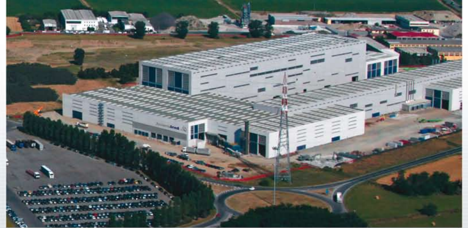
Una vista aerea della parte dell' Acciaieria Arvedi destinata alle linee di decapaggio, zincatura e preverniciatura dei coils
