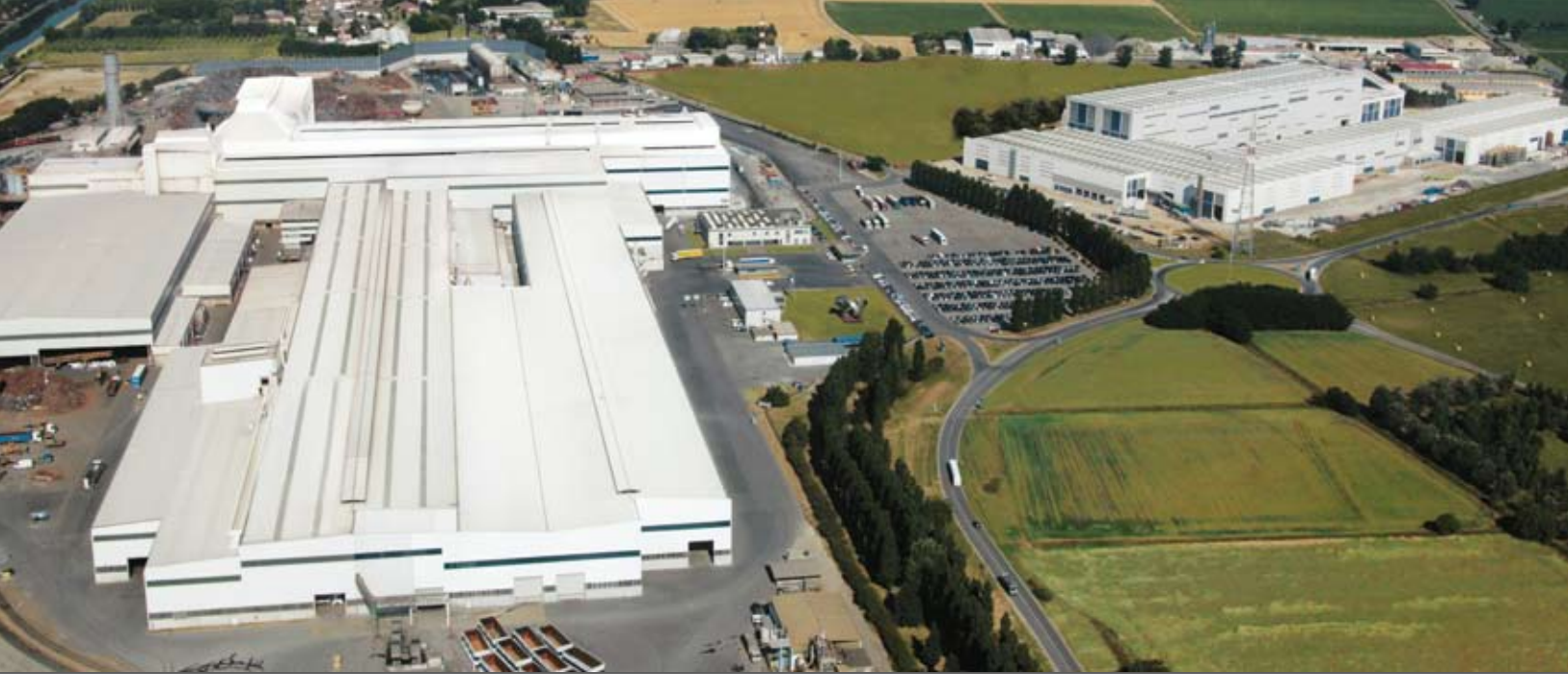
Veduta aerea dell'Acciaieria e dei nuovi impianti di finitura
