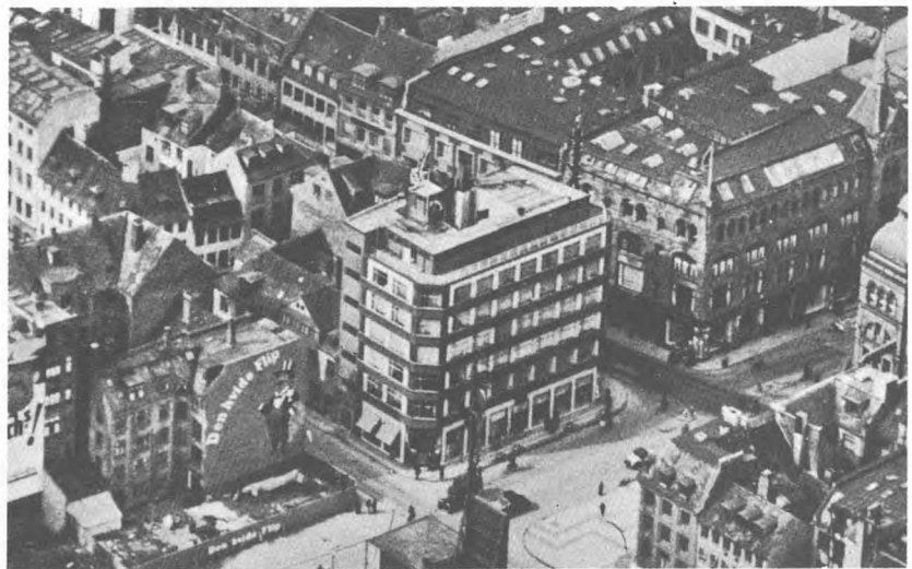
Luftfoto af det nye Torv midt paa Strøget. Midt i Billedet ses Pelsvarefirmaet A. C. Bangs nye Hus, helt i Forgrunden et Hjørne af Magasin du Nord nye Salgshal.
