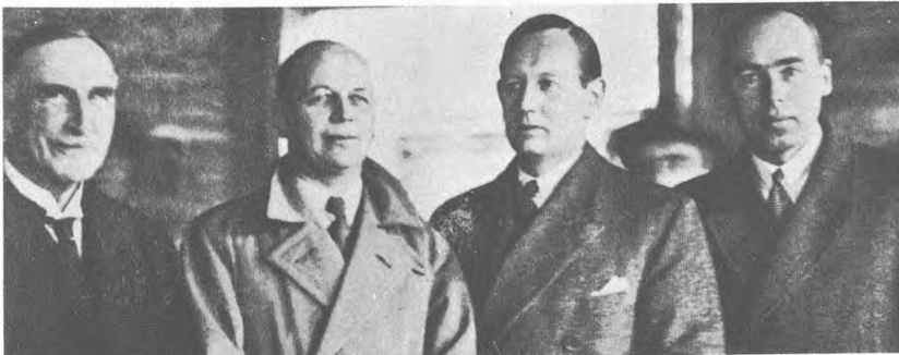
Fra Rejsegildet paa Bangs nye Hus. Fra venstre til højre ses ORS. Axel Bang, Arkitekt Helweg-Møller, Direktør Aage Bang og Ingeniør Friis-Jespersen.
