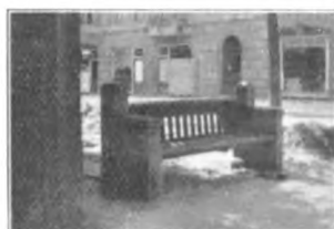
Fig. 7. Betonbænk fra Pilealleen.
