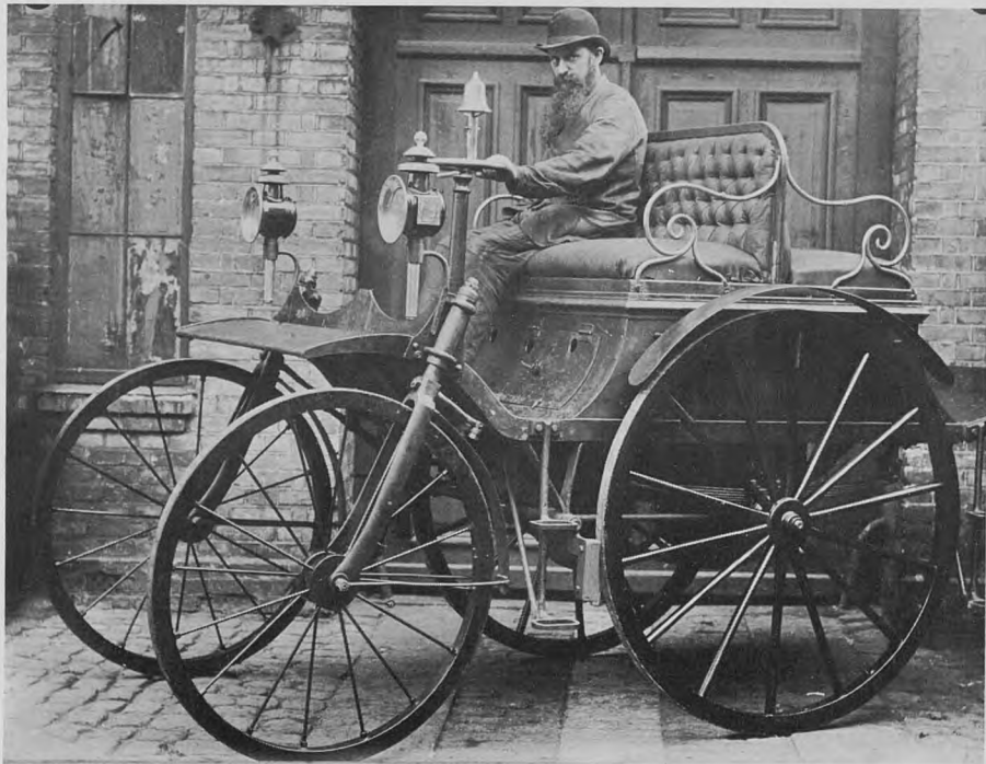
Fabrikant Hammel i sin bil fra 1887, som han med god grund var stolt af. I dag er Hammel-bilen den store attraktion på Teknisk Museum. Hjul, bremses og affjedring er hentet fra hestevognen, mens forhjulsgaflerne er en nykonstruktion.
