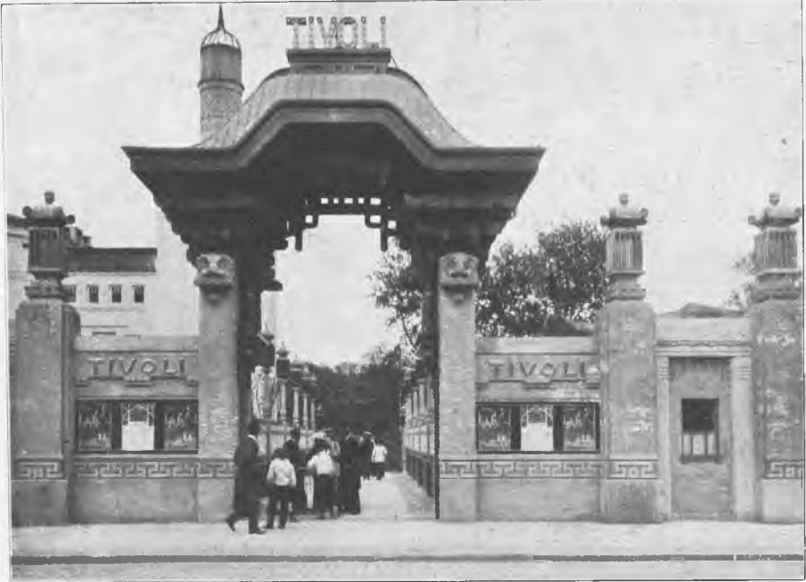
Indgangen fra Bernstorffsgade, opført 1912.
