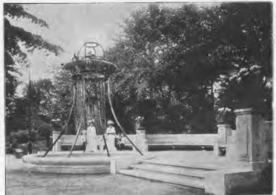
Springvand ved Seen.
