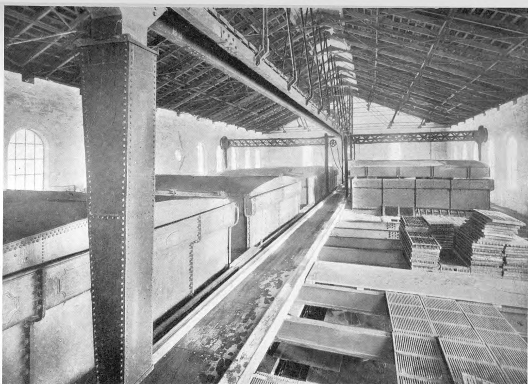
Øverste Etage af Renshuset paa Finsensvej ca. 1900. Taget er overflyttet fra Retorthuset paa Ørstedvej.
