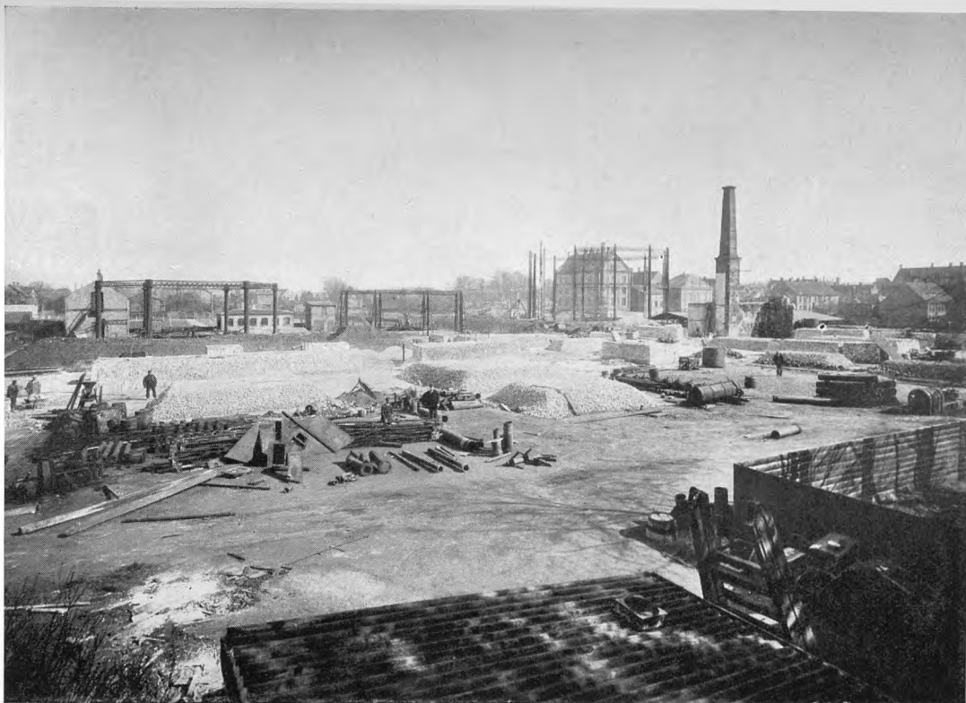
Fra Nedrivningen af det gamle Værk paa Ørstedvej ca. 1896.
