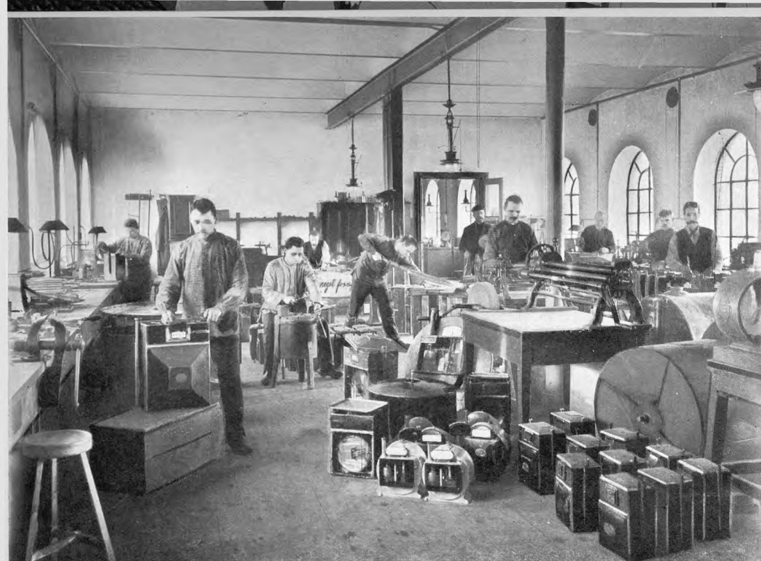
Maalerværkstedet paa Gasværket paa Finsensvej ca. Aar 1900.
