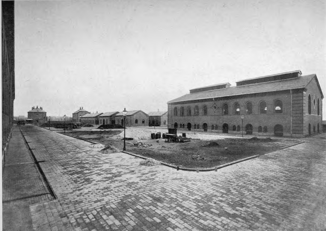
Det første Gasværk paa Finsensvej set inde fra Pladsen.
