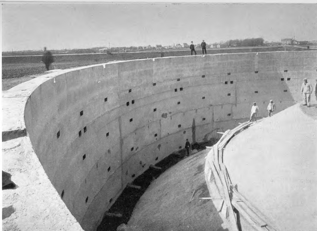
Fra Opførelsen af den store Gasbeholder paa Finsensvej. 1912.
