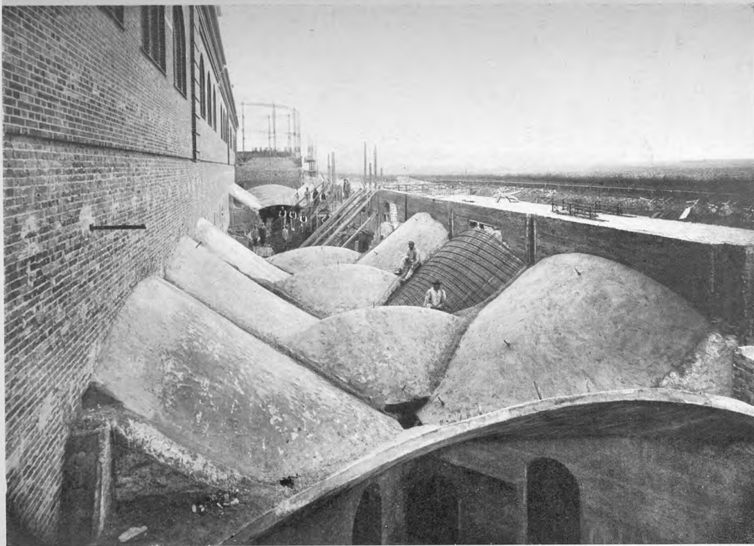
Kulsiloer under Opførelse paa Finsensvej i Slutningen af 1890'erne.
