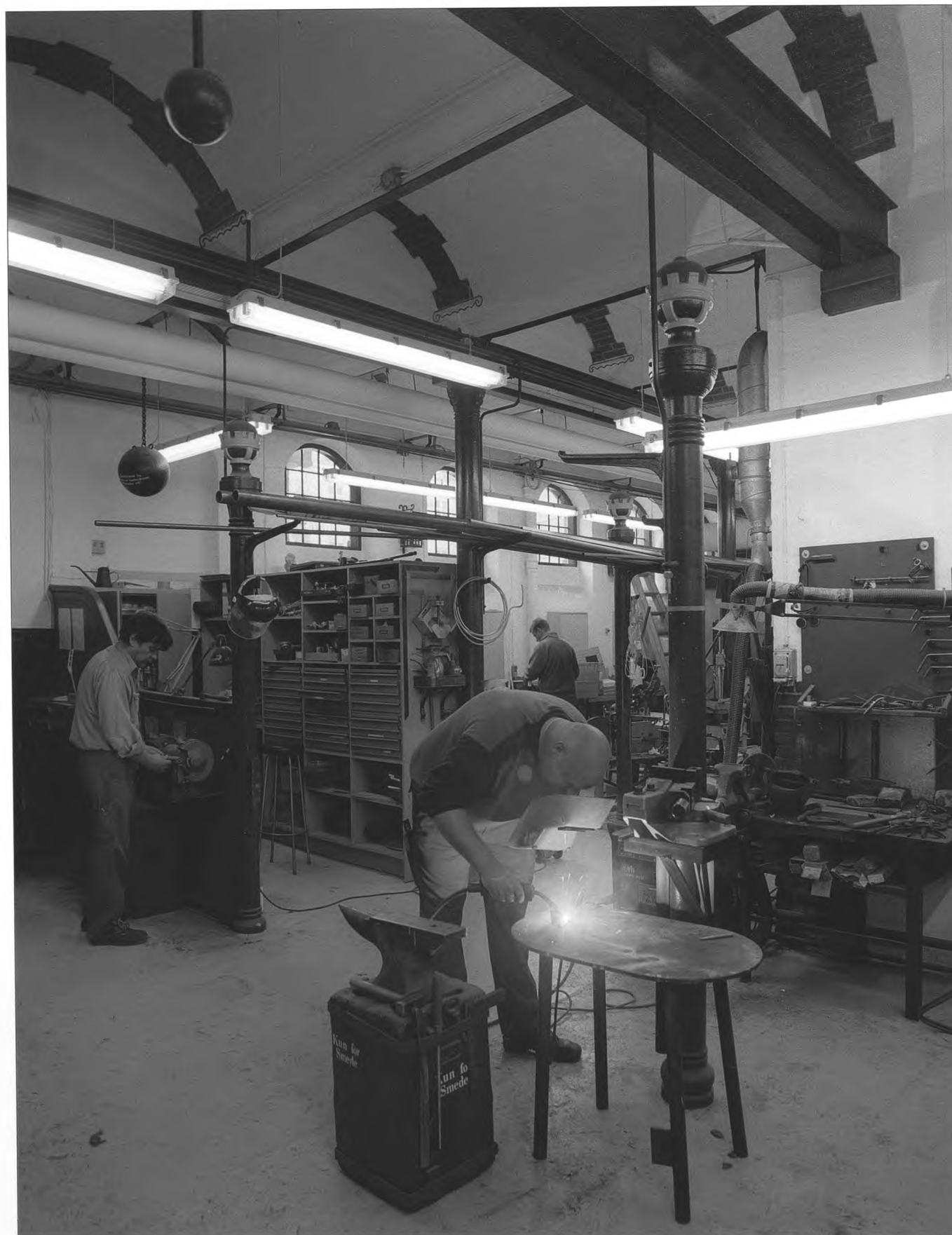
I kedelhuset havde Politiet hestestald. Den fungerer nu som værksted for Rådhusets teknikere, og det gamle kedelrum er efter fjernvarmen indrettet til arkiv og lager.
