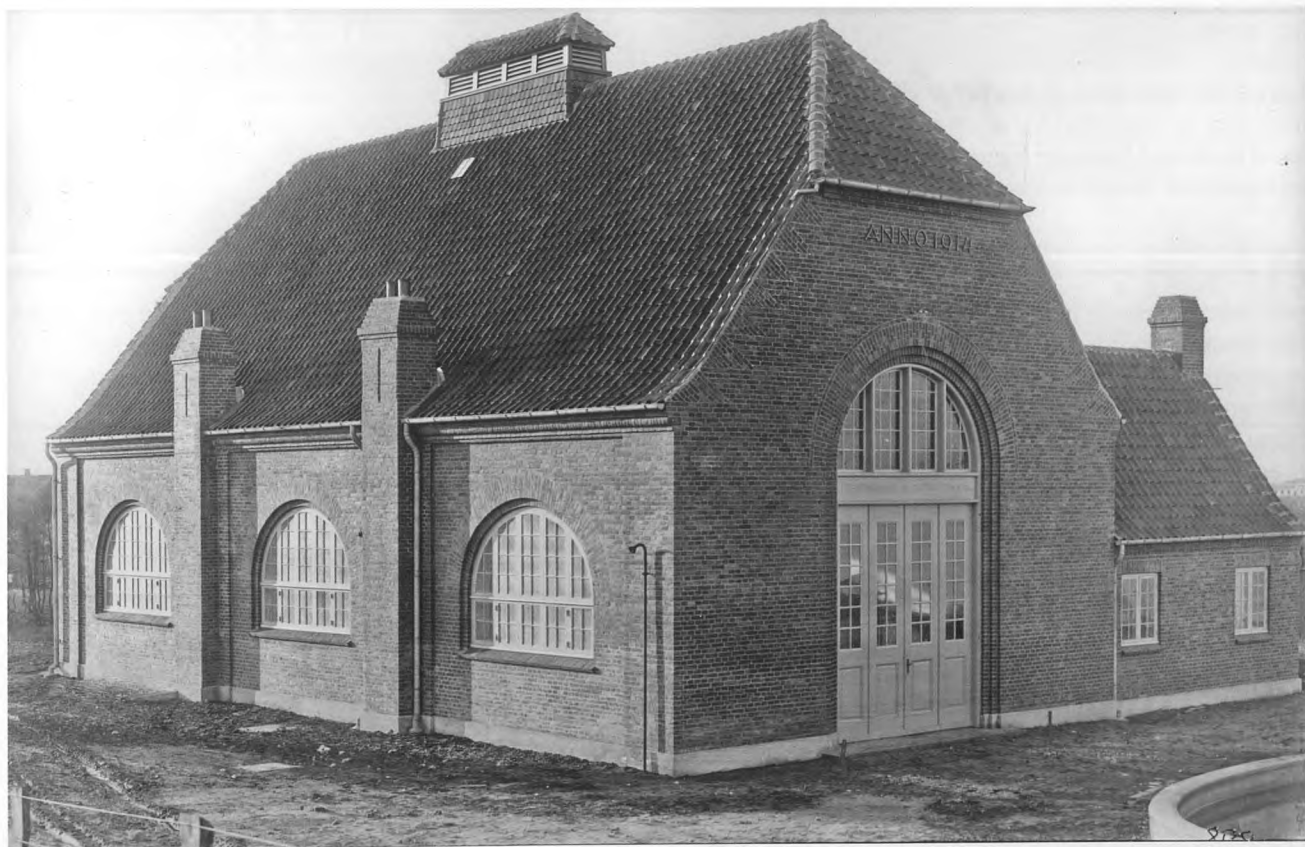
Det nyopførte elværk i 1914. Foto: Johannes Hansen.
