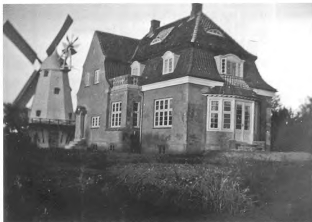
Bagermester Lars Peter Hansens villa, der var tegnet af arkitekt Gerhard Rønne. Oprindeligt opført i Gentofte, men pillet ned og flyttet til Frederikssund i 1938.
