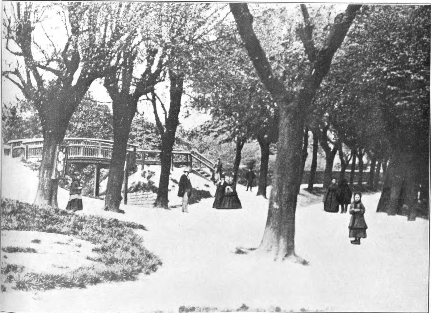
Nedgangen til Teglgårdsbroen i 1860erne (Nørrevold).
