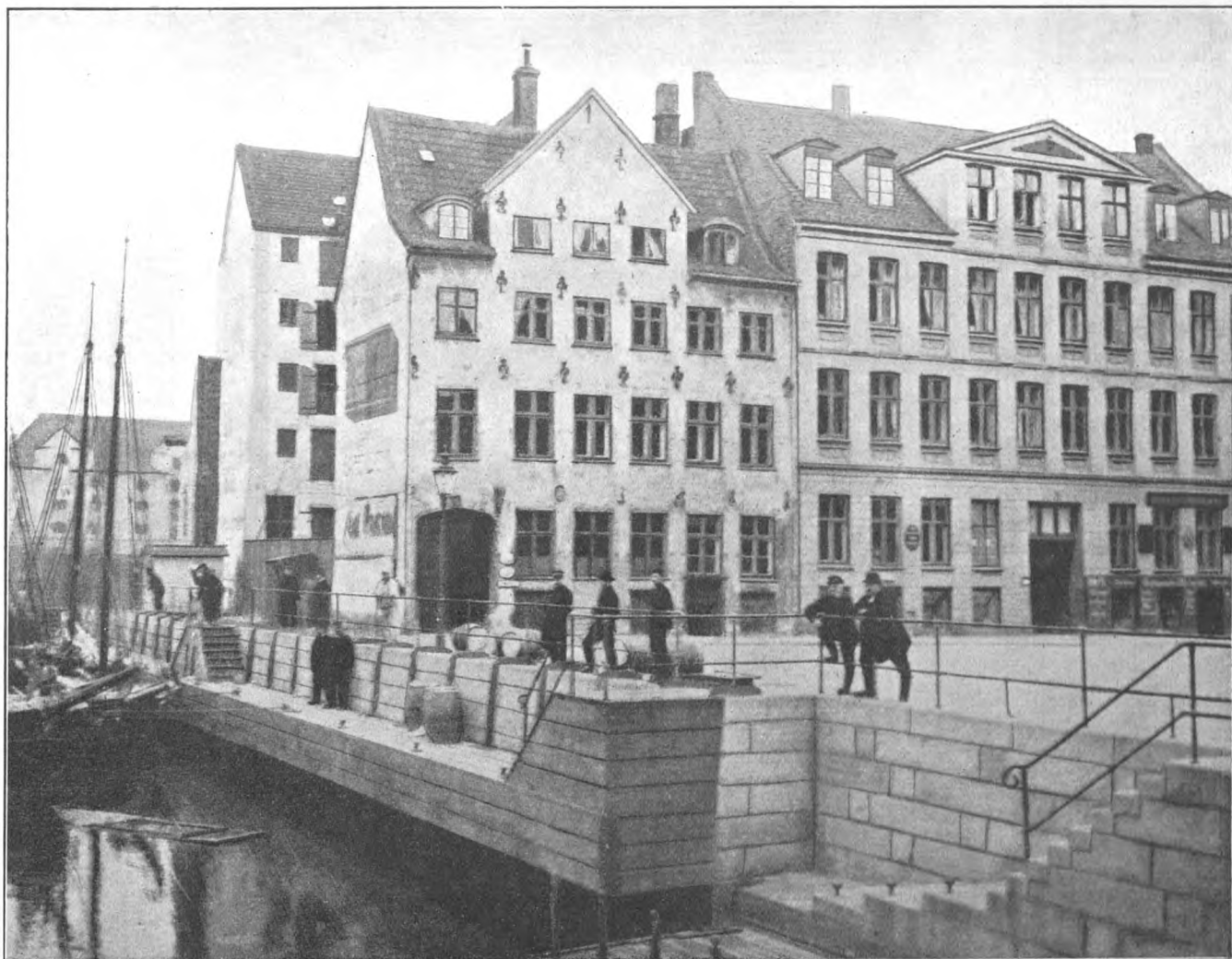
Bolværket ved Brogade efter Reguleringen, efterat den anden Knippelsbro forsvandt 1909. Huset Nr. 1 maatte nedrives for at gøre Løbe: bredere, Nr. 3, Reimer Wildes Gaard, opført 1688, blev sparet. Billedet venligst tilstillet os til Reproduktion af Hr. Haynedirektør Møller.
