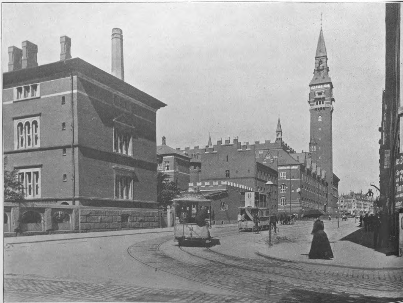
Vestervold-Terrænet, som det nu ser ud paa Strækningen fra Stormgade til Raadhuspladsen (tidligere Halmtorvet). Bygningerne fra venstre til højre er Overformynderiet, Raadhusets Varme-Anstalt, Hovedbrandstationen og Raadhuset.
