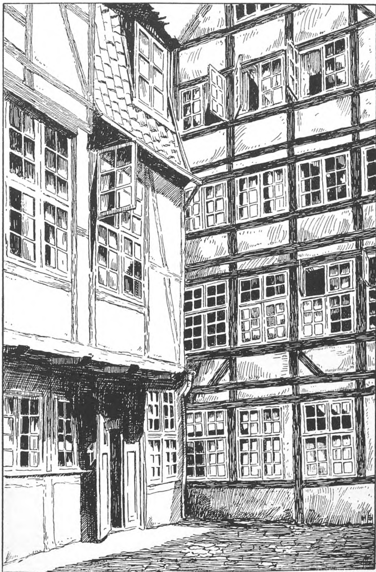
AMALIEGADE 21. GAARDINTERIØR. BINDINGSVÆRK
