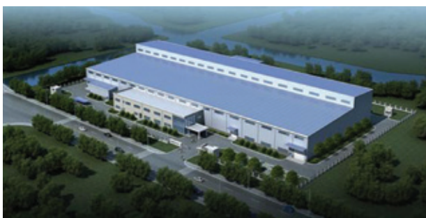
○ Nippon Steel & Sumitomo Metal Corp新工厂的模型。照片由Nippon Steel and Sumitomo Metal Corp提供
